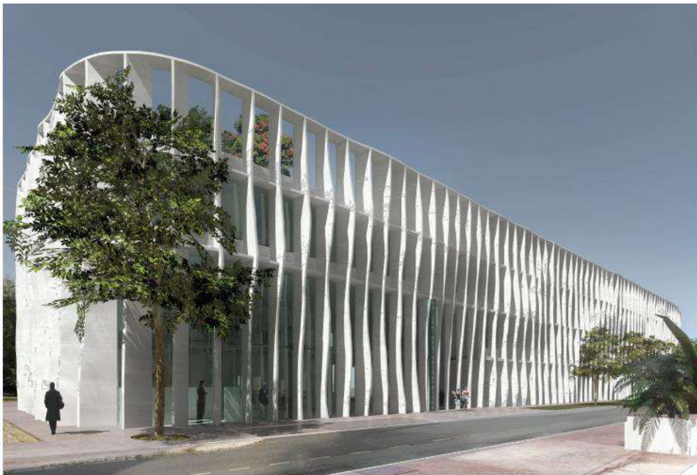
VUE DEPUIS LA RUE DE L'ELECTRICITE MONTRANT UP! Le Carré des Entrepreneurs®
